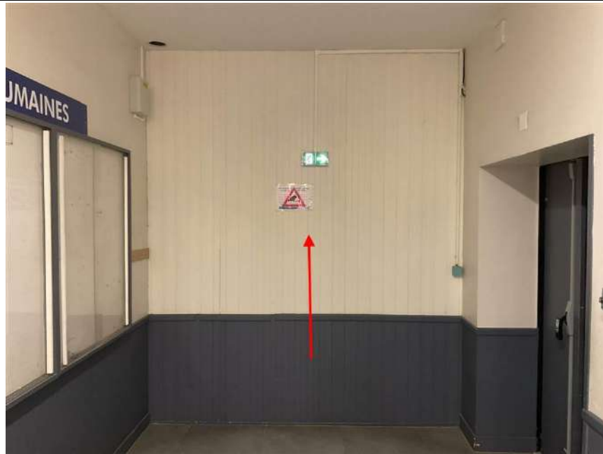
Photo n° PhDch045 Localisation : COULOIR SALLE DE CHARGE - RDC Description : panneaux de bois
