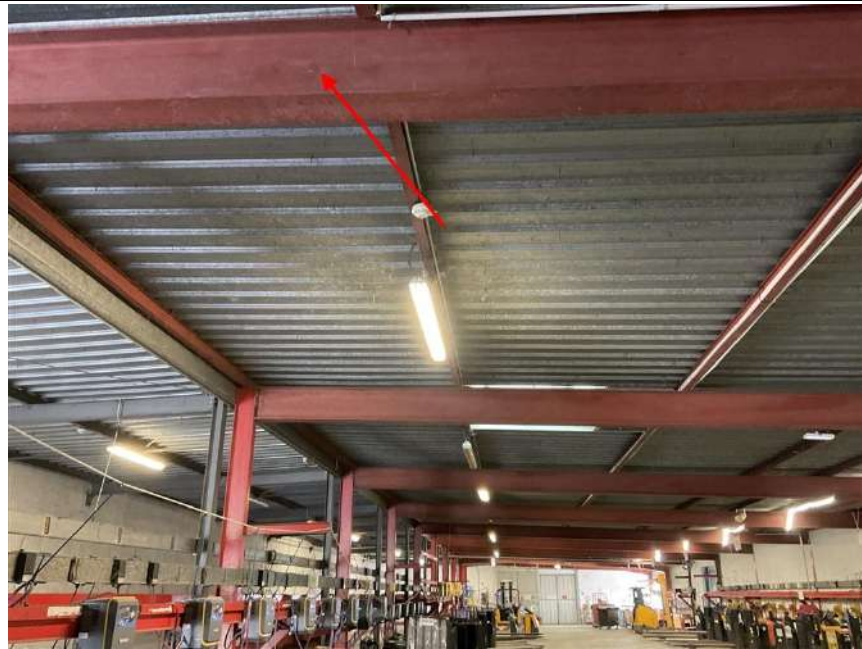
Photo n° PhDch031 Localisation : SALLE DE CHARGE/ATELIER Description : IPE (360 mm)
