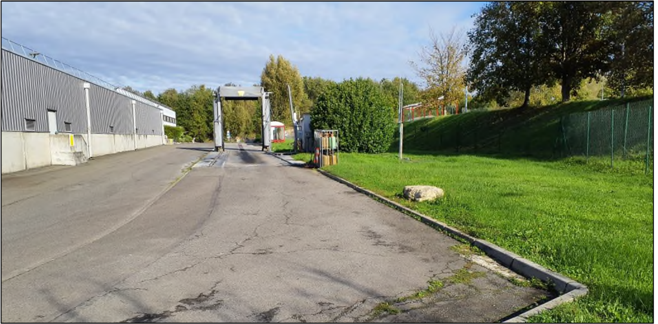
Photographie du talus 4 depuis l'Ouest
