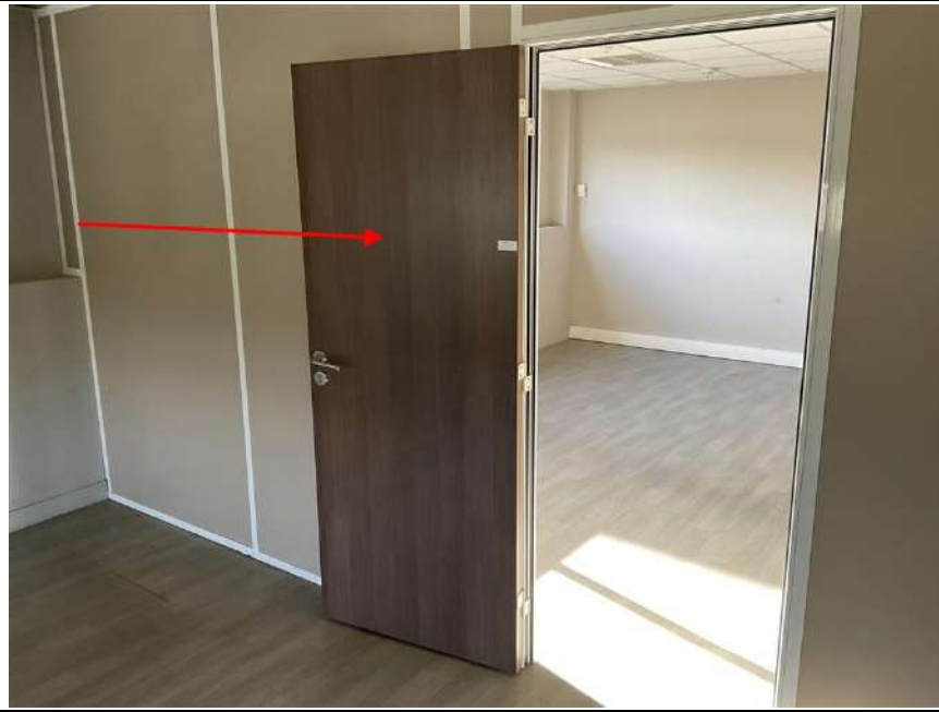
Photo n° PhDch016 Localisation : ADMINISTRATIF - BUREAUX RDC Description : Portes pleines 202X82X4
