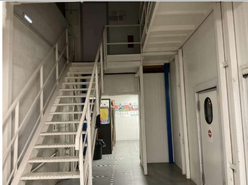
Photo n° Ph1 Localisation : COULOIR SALLE DE CHARGE - R+1 Description : escalier métal
