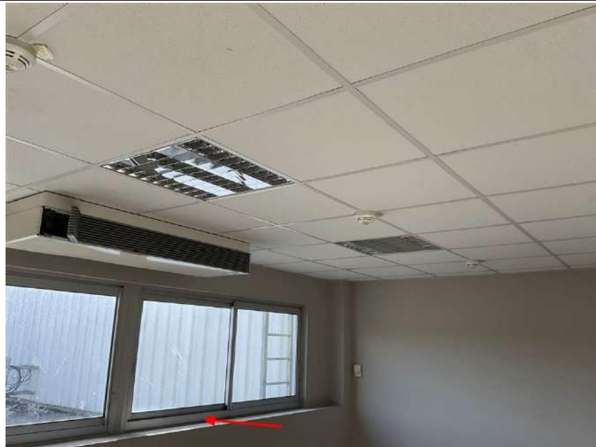
Photo n° PhDch069 Localisation : ADMINISTRATIF - BUREAUX 1 ER Description : dormant menuiseries alu
