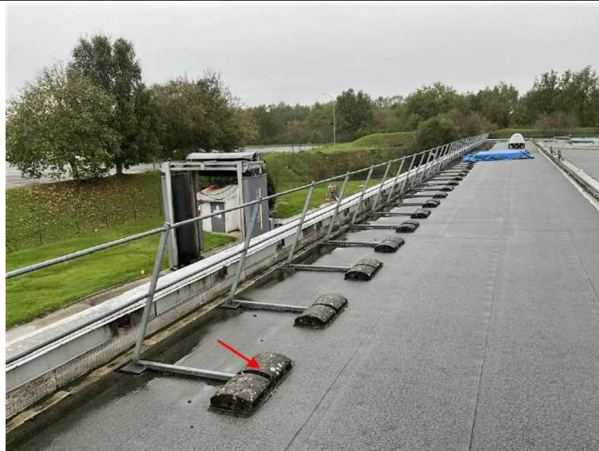
Photo n° PhDch080 Localisation : ENTREPOT FRAIS - SANITAIRES Description : Plot béton garde corps toiture terrace 30X30 cm
