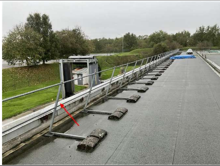
Photo n° PhDch079 Localisation : TOITURE TERRASSE Description : couvertine
