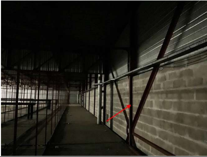
Photo n° PhDch052 Localisation : ADMINISTRATIF - VESTIAIRE HOMMES, ENTREPOT FRUITS, COULOIR SALLE DE CHARGE - RDC, COULOIR SALLE DE CHARGE - R+1
