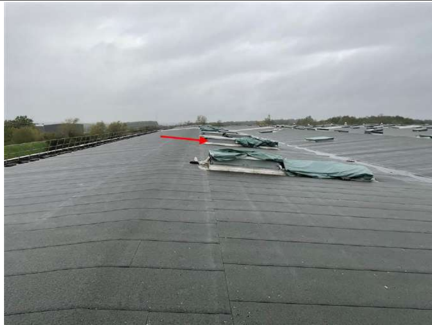
Photo n° PhDch120 Localisation : TOITURE TERRASSE Description : chassis lanterneaux
