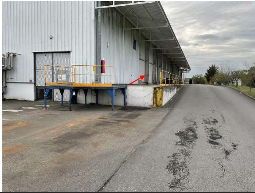
Photo n° PhDch089 Localisation : ADMINISTRATIF - BUREAUX RDC Description : IPE 500
