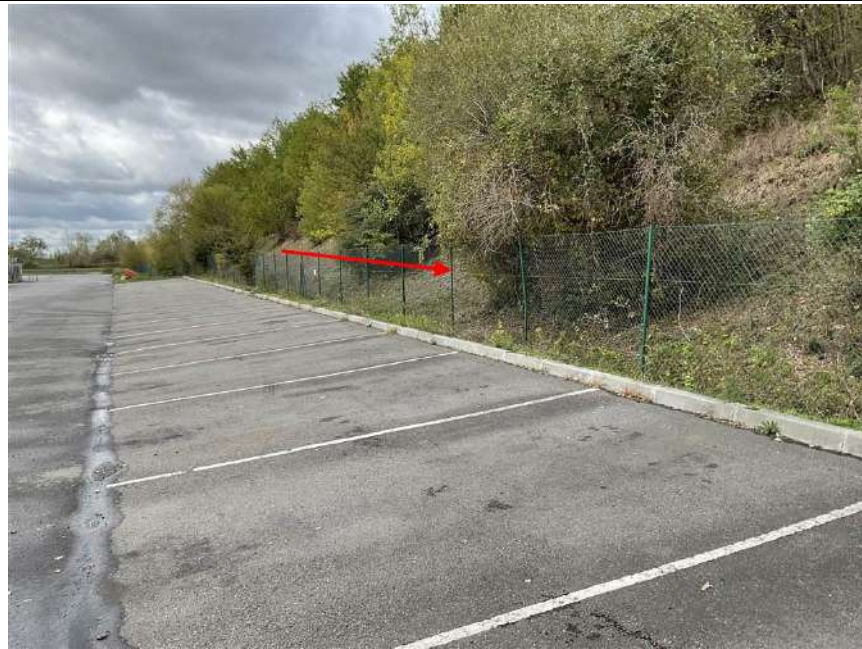
Photo n° PhDch071 Localisation : EXTERIEUR Description : piquets métal ( 40 mm)
