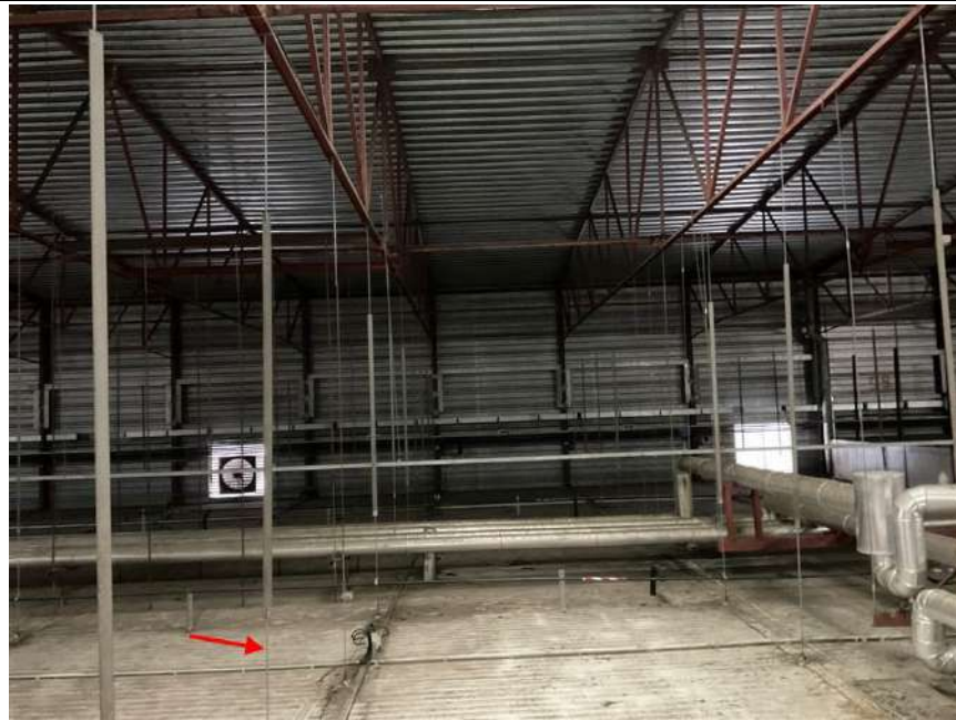
Photo n° PhDch084 Localisation : COMBLES Description : tiges acier support combles 0,5mm
