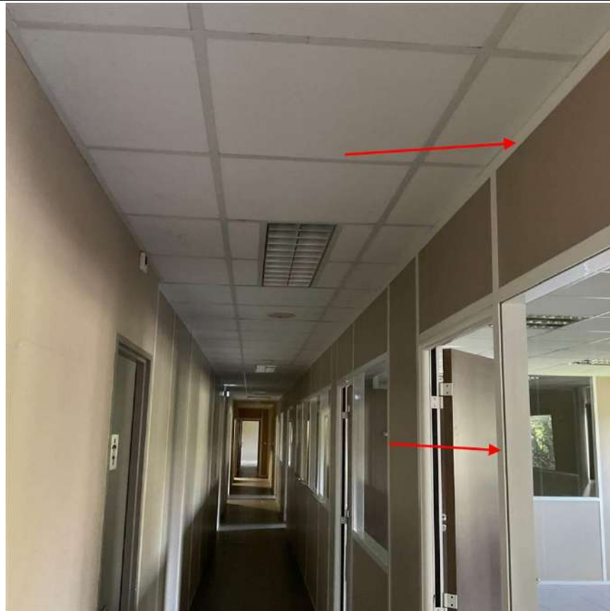
Photo n° PhDch065 Localisation : ADMINISTRATIF - BUREAUX RDC, ADMINISTRATIF - BUREAUX 1 ER Description : structure acier panneaux de cloisons 40mmX2mm
