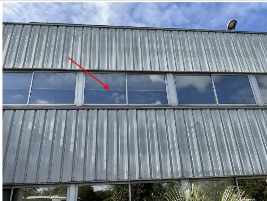
Photo n° PhDch067 Localisation : ADMINISTRATIF - BUREAUX 1 ER Description : alu+verre simple vitrage
