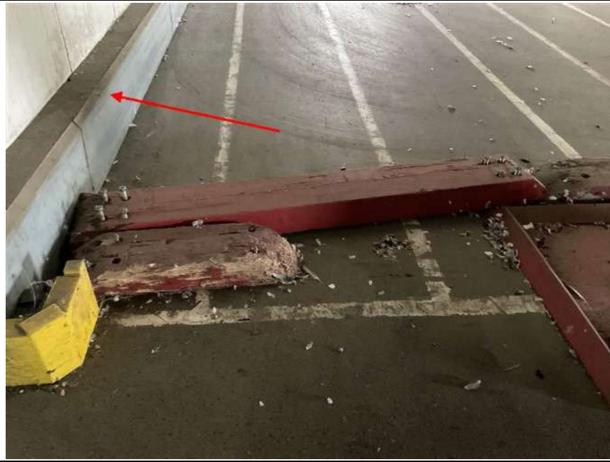
Photo n° PhDch083 Localisation : ENTREPOT GEL Description : muret périphérique
