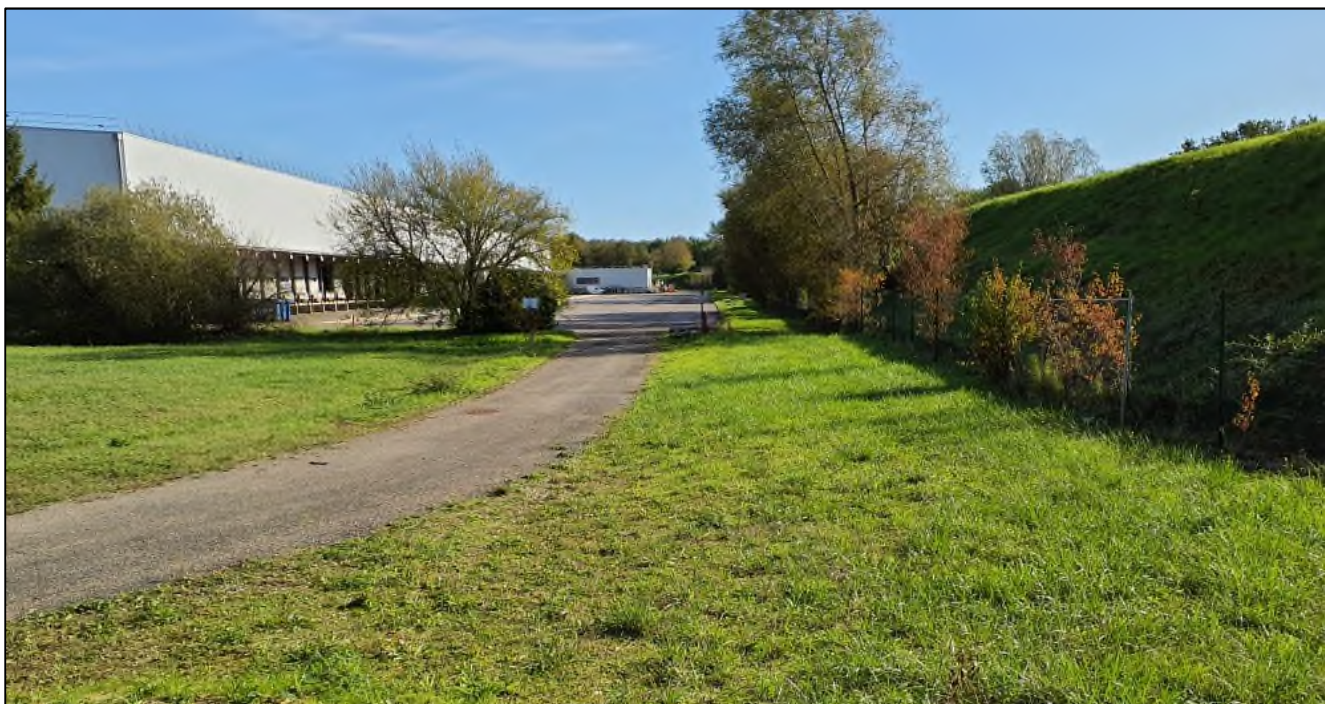
Photographie du talus 2 depuis l'Ouest
