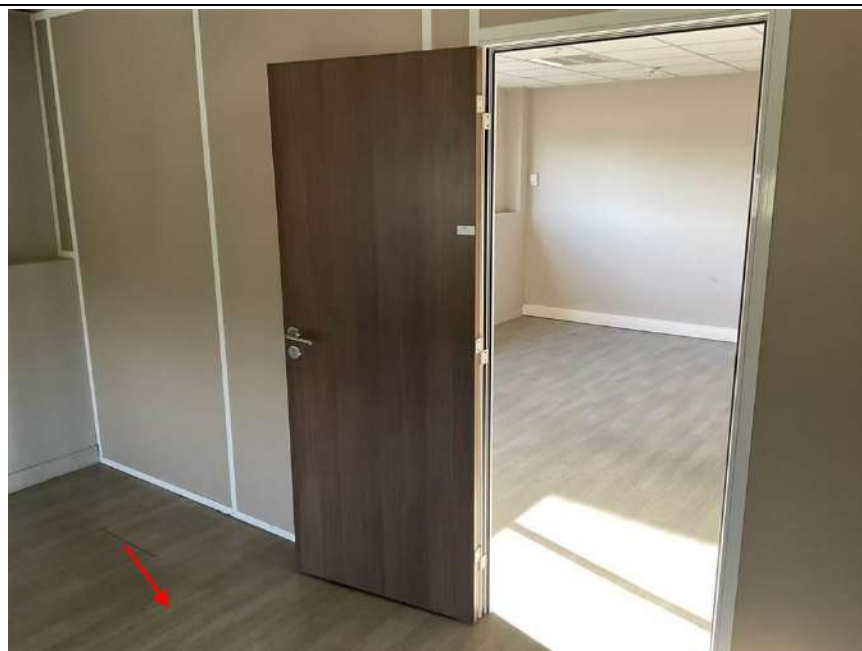
Photo n° PhDch060 Localisation : ADMINISTRATIF - VESTIAIRE HOMMES Description : Dalles pvc
