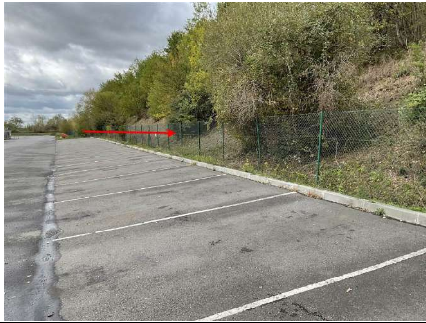
Photo n° PhDch070 Localisation : ADMINISTRATIF - BUREAUX 1 ER Description : cloture souple métal
