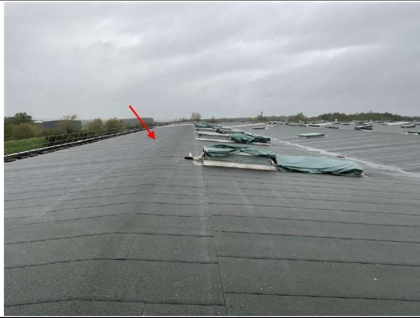
Photo n° PhDch081 Localisation : ENTREPOT FRAIS - SANITAIRES Description : étanchéités bitume
