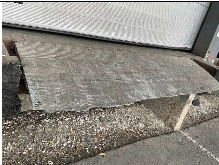
Photo n° PhDch103 Localisation : ENTREPOT FRAIS Description : rampe de chargement alu
