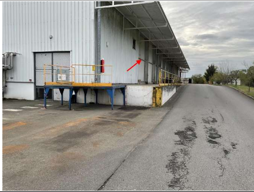
Photo n° PhDch038 Localisation : EXTERIEUR Description : IPE ( 160 mm)
