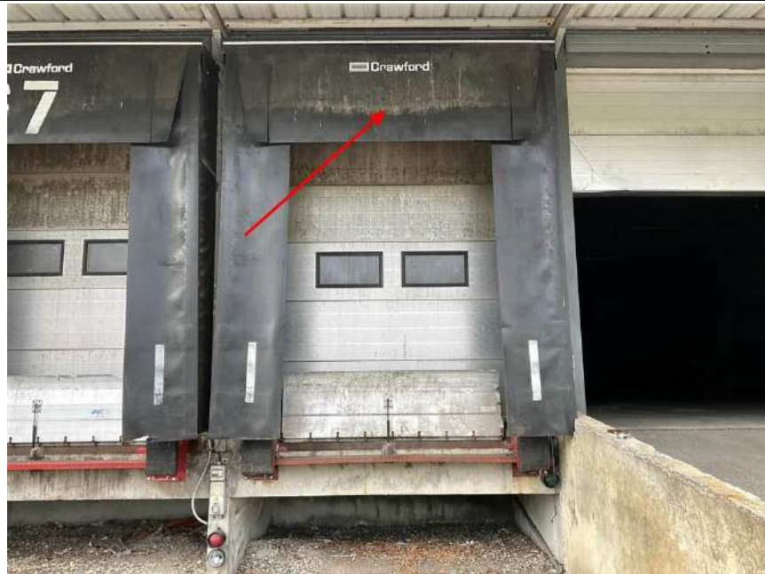
Photo n° PhDch105 Localisation : ENTREPOT GEL, ENTREPOT VENTILATION, ENTREPOT FRAIS, ENTREPOT FRUITS, EXTERIEUR Description : Sas de quai pvc
