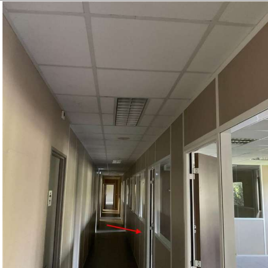
Photo n° PhDch063 Localisation : ADMINISTRATIF - BUREAUX 1 ER Description : plaques de platre panneaux de cloisons
