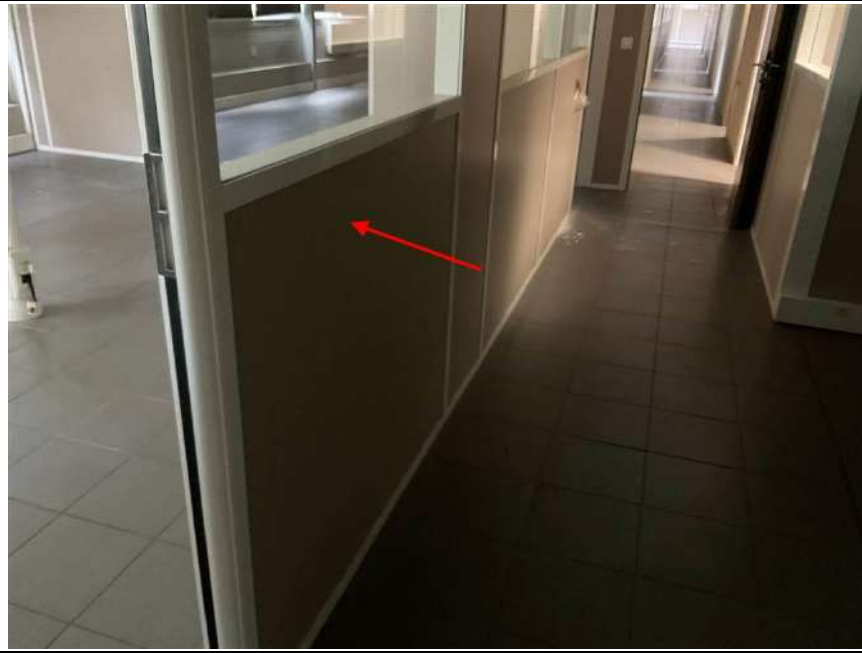
Photo n° PhDch064 Localisation : ADMINISTRATIF - BUREAUX 1 ER Description : isolant 40 mm
