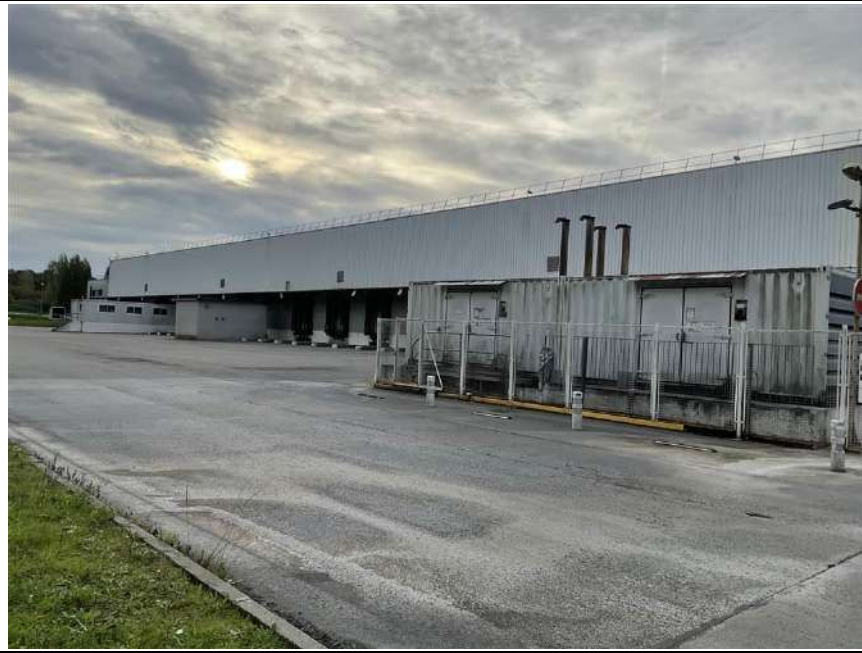
Photo n° PhDch127 Localisation : EXTERIEUR Description : groupes electrogenes
