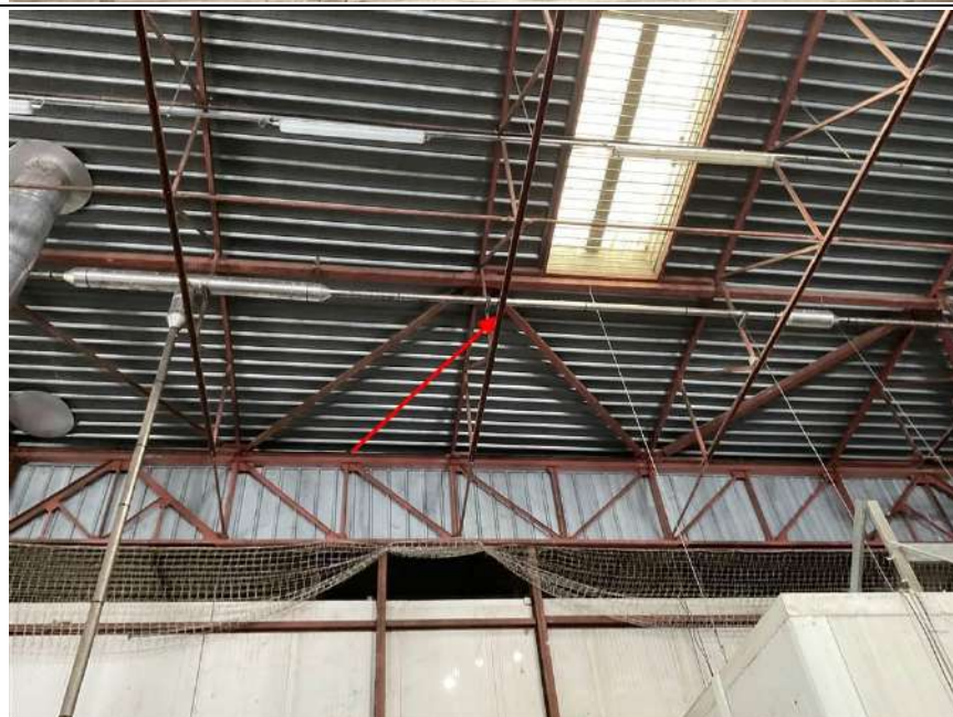
Photo n° PhDch122 Localisation : ADMINISTRATIF - BUREAUX RDC Description : charpente métallique
