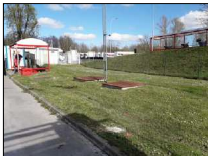
Cuve de carburant
