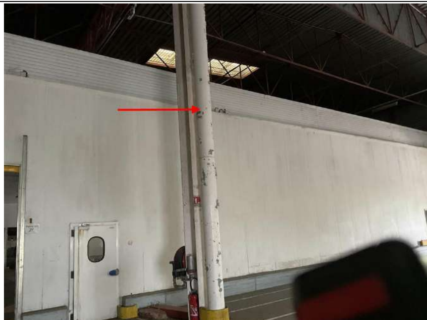
Photo n° PhDch086 Localisation : ENTREPOT GEL, ENTREPOT VENTILATION, ENTREPOT FRAIS, ENTREPOT FRUITS Description : EP fonte 250 mm
