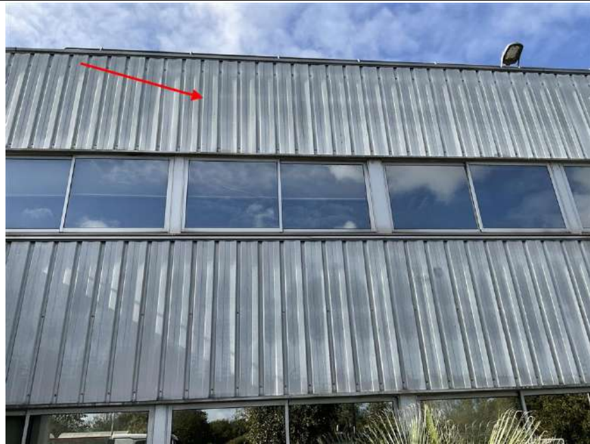
Photo n° PhDch013 Localisation : ADMINISTRATIF - BUREAUX RDC Description : bardage métal double peau
