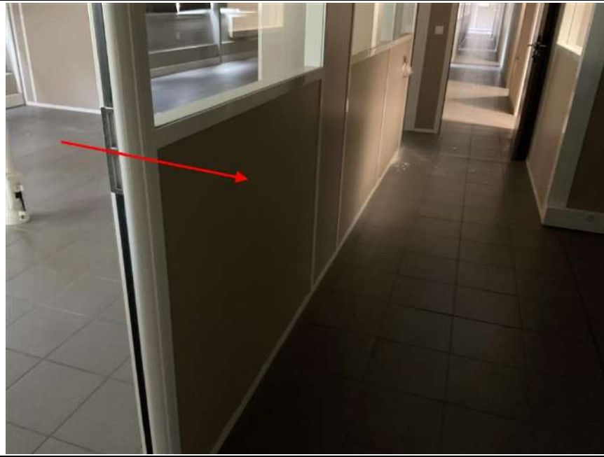
Photo n° PhDch010 Localisation : ADMINISTRATIF - BUREAUX RDC Description : placo mur
