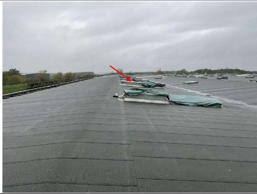
Photo n° Ph9 Localisation : TOITURE TERRASSE Description : polycarbonate lanterneaux
