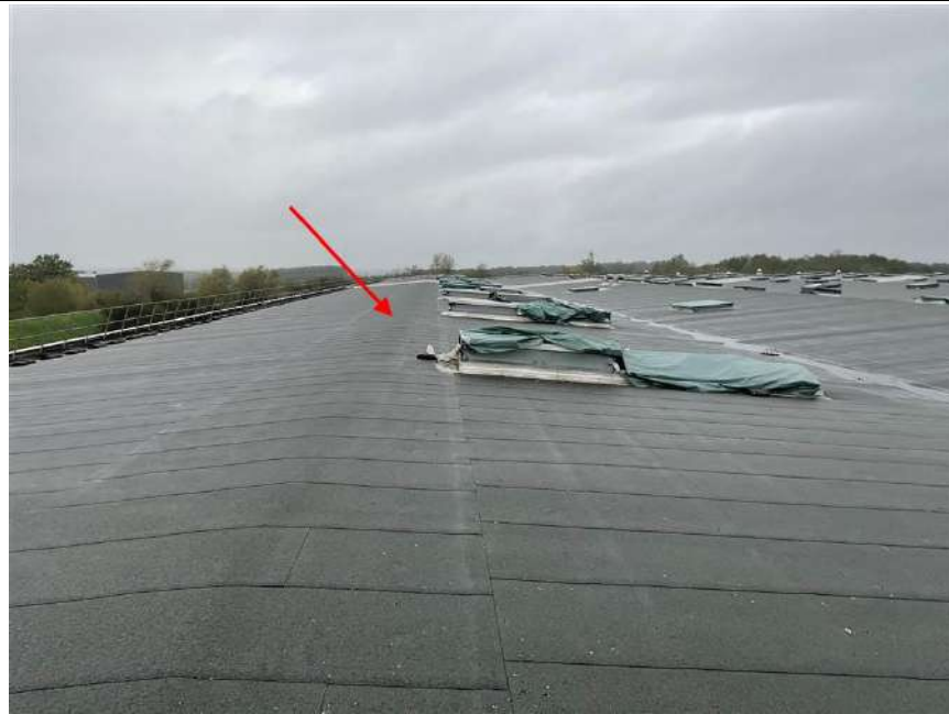
Photo n° PhDch082 Localisation : EXTERIEUR Description : membrane bitume épaisseur 3 cm
