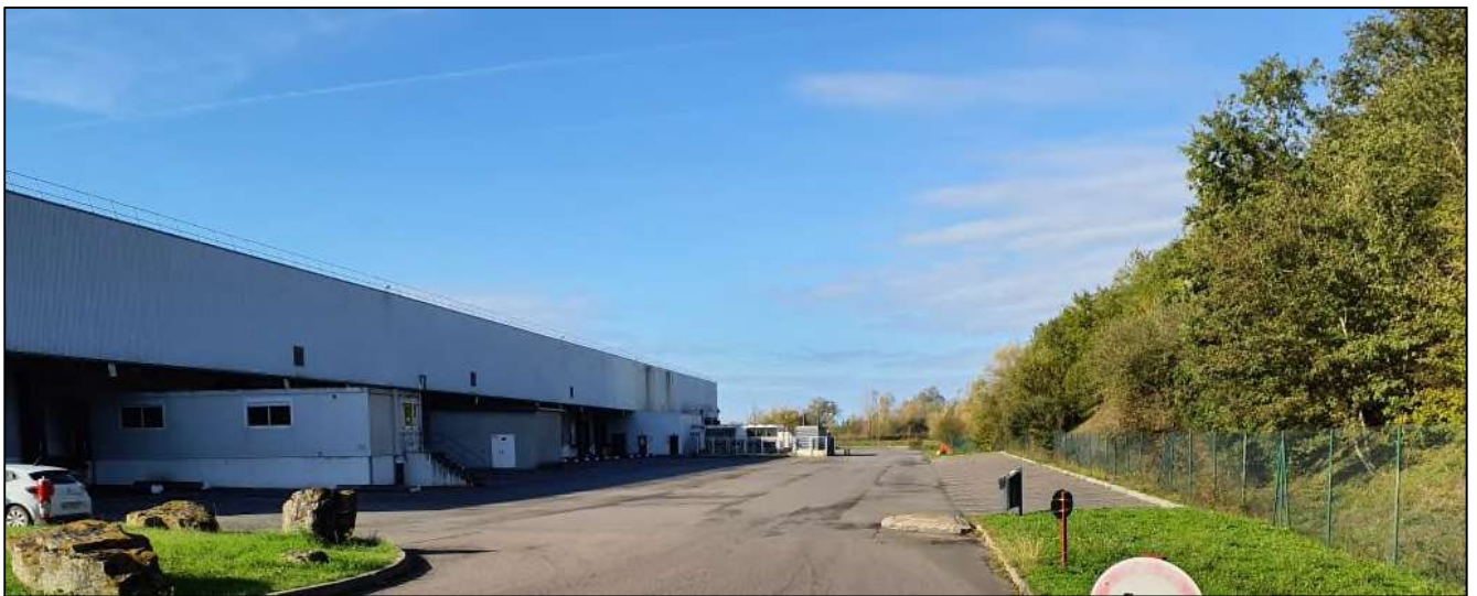
Photographie du talus 1 depuis l'Est
