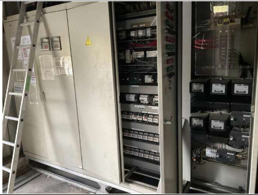
Photo n° PhDch123 Localisation : ADMINISTRATIF - BUREAUX RDC Description : XXX
