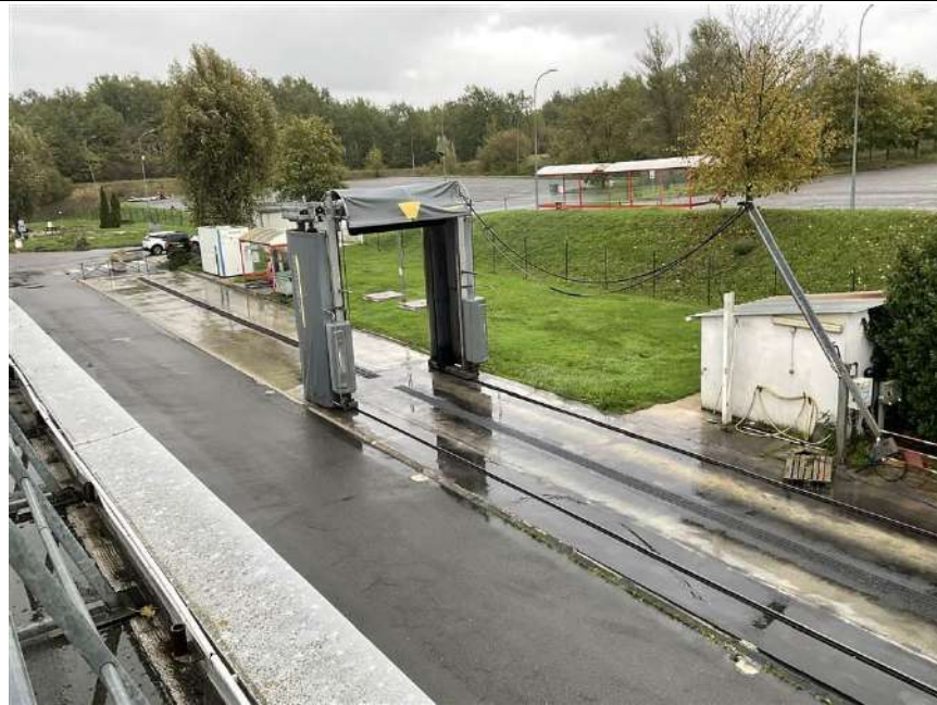
Photo n° PhDch128 Localisation : EXTERIEUR Description : STATION DE LAVAGE
