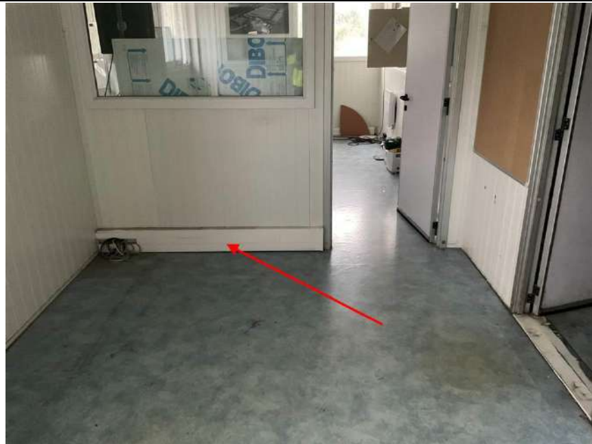
Photo n° PhDch109 Localisation : COULOIR SALLE DE CHARGE - R+1 Description : Goulottes PVC ( 130X55 mm)
