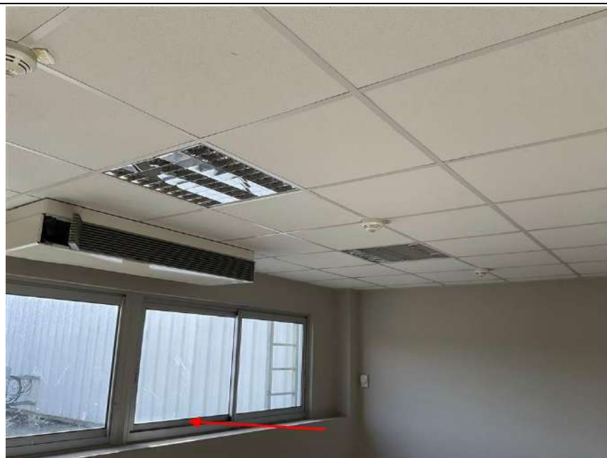
Photo n° PhDch068 Localisation : ADMINISTRATIF - BUREAUX 1 ER Description : menuiseries ext 2,5X1,15
