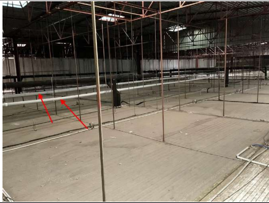
Photo n° PhDch093 Localisation : COMBLES Description : cheneaux PVC
