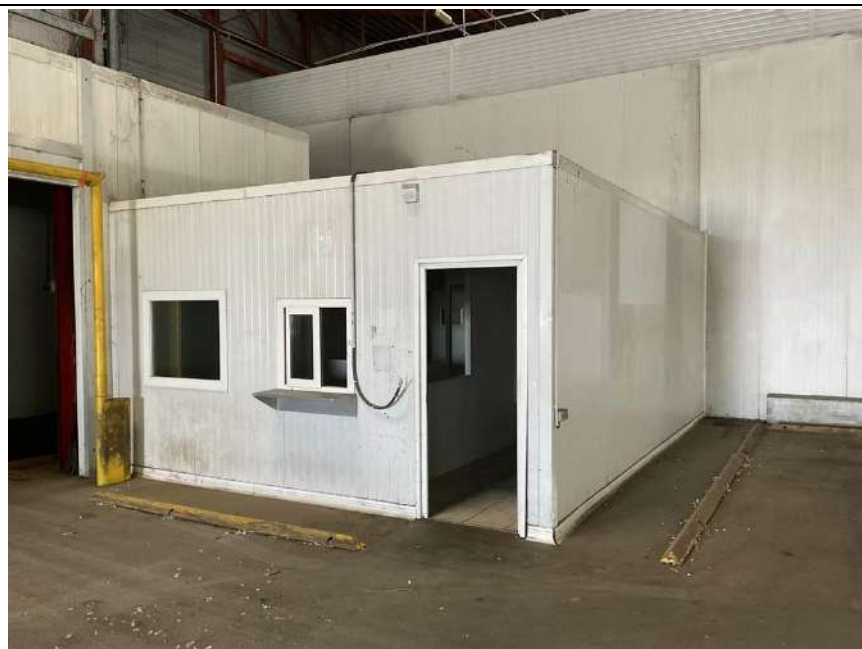
Photo n° PhDch099 Localisation : ENTREPOT GEL Description : panneaux sandwichs isothermes 6 cm
