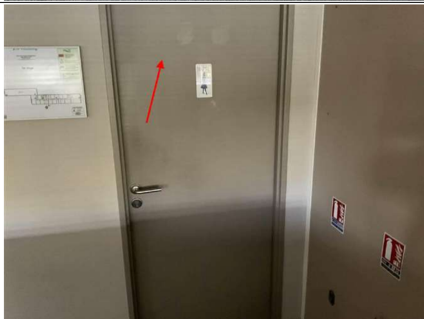
Photo n° PhDch075 Localisation : ADMINISTRATIF - BUREAUX 1 ER Description : Portes pleines 202X82X4
