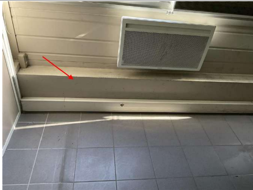
Photo n° PhDch011 Localisation : ADMINISTRATIF - BUREAUX RDC Description : muret béton périphérique
