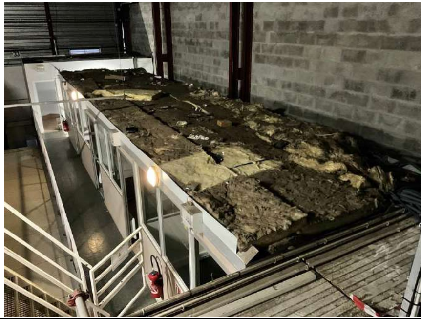
Photo n° PhDch095 Localisation : ENTREPOT FRAIS Description : Laine de verre 200 mm
