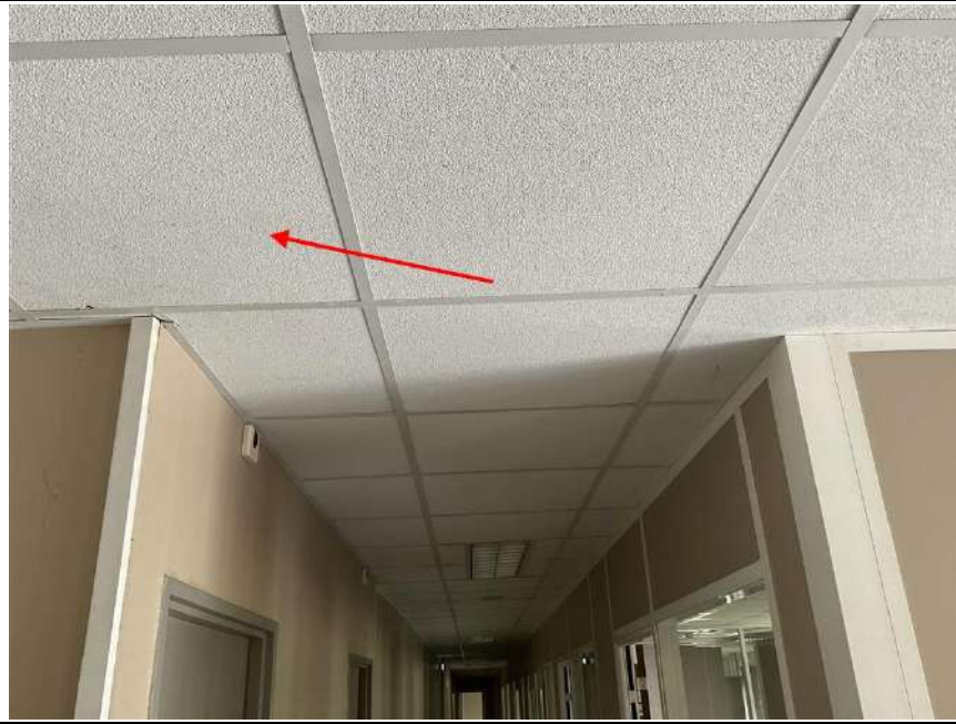
Photo n° PhDch012 Localisation : ADMINISTRATIF - BUREAUX RDC, ADMINISTRATIF - BUREAUX 1 ER Description : dalles de faux plafond
